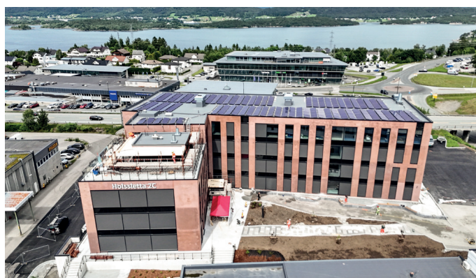
Solcelleanlegget på taket skal levere 135 kWh, en fjerdedel av energibehovet for bygget. Her Holsletta 2C sett fra sør, med eksisterende industribygg på tomte i nedre bildekant.
