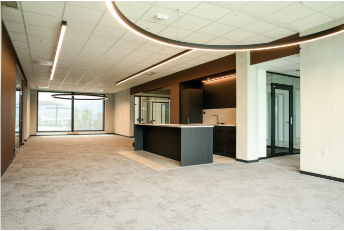
Fra et av fellesområdene i bygget. Legg merke til den påkostede belysningen i taket. Her er teppeflis på gulv, systemhimling og eksponert betong. Sigdal har levert kjøkken.
