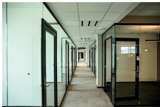
Fleksible modulvegger fra Moelven Modus er satt opp til inndeling av kontorer rundt en kjerne av stedbygde rom midt i etasjen
