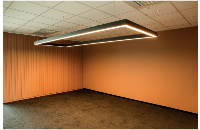
Et av møterommene i bygget i kjernen av etasjen med stedbygde vegger. Her er teppeflis på gulv, sparklet og malt gips på vegger i kombinasjon med trespiler, og systemhimling i tak.
